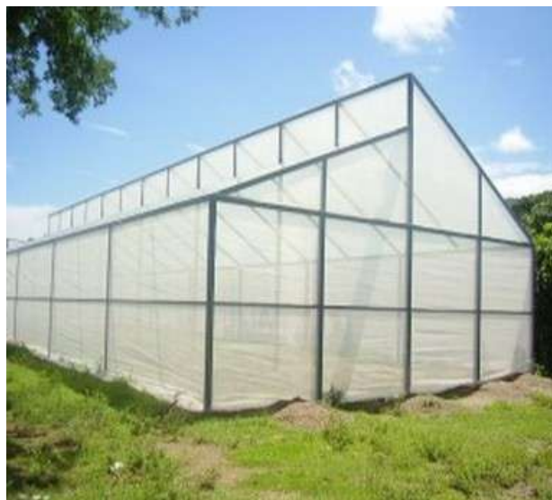
Figura 7. Ejemplo Gráfico de Invernadero Asimétrico o Inacral
