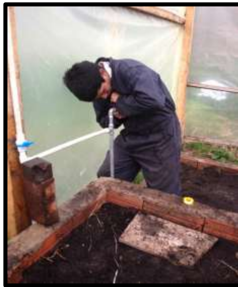
Ilustración 11. Proceso de construcción conexión inicial de tubos
