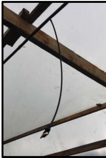
Ilustración 12. Registro fotográfico Conexión de Nebulizador a la línea de Riego.
