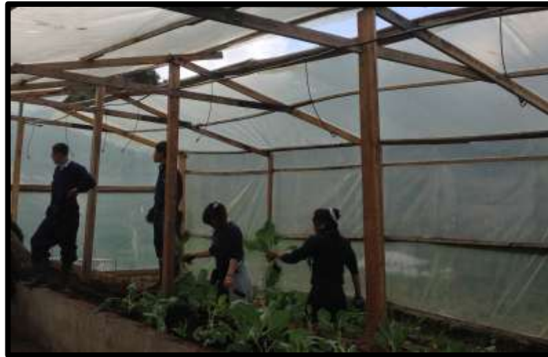
Ilustración 13. Registro Fotográfico primera conexión Línea de Riego Central del invernadero.
