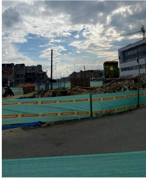
Figure 2. Figure 11. Construcción Estación 2 Metro y Hospital sobre Av. Tintal
