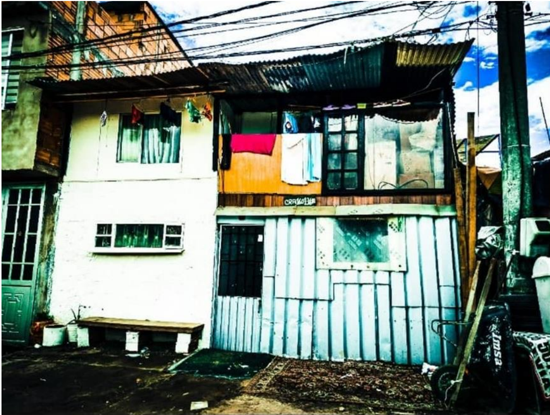
Casa sin servicios públicos de alcantarillado, Villa Cindy, 2021. Fotografía: Leidy Ortiz
