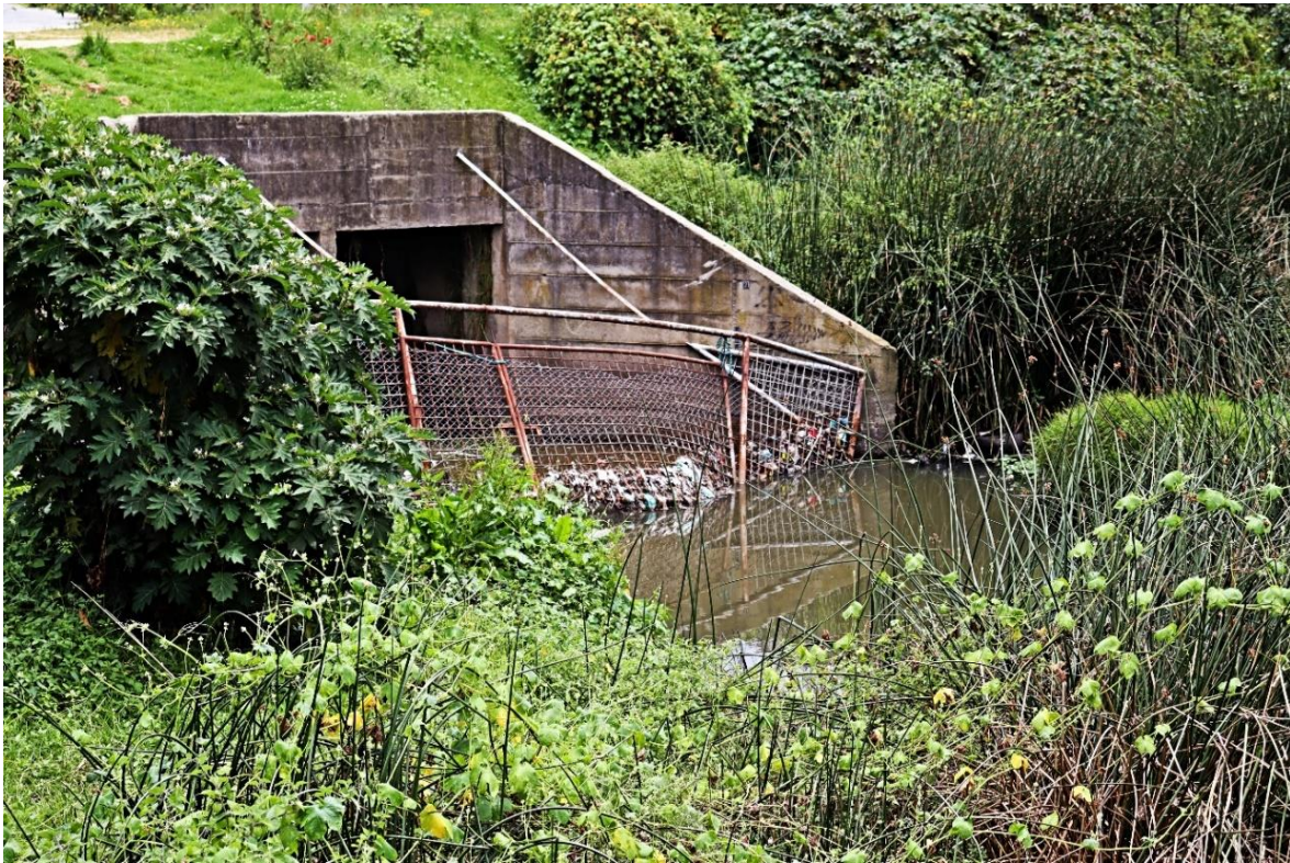
Canal de aguas lluvias, humedal Tibabuyes, Suba, año 2022. Fotografía: Viviana Bocanegra
