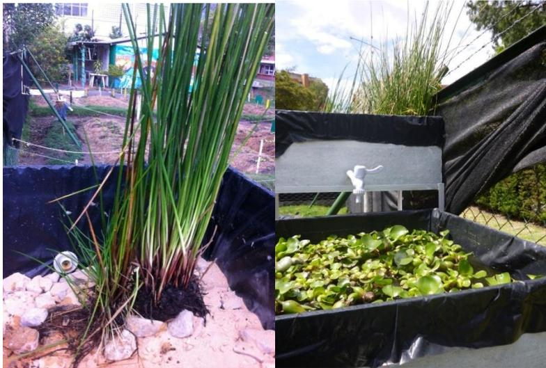
Imagen 25 Siembra de planta enraizada y planta flotante
