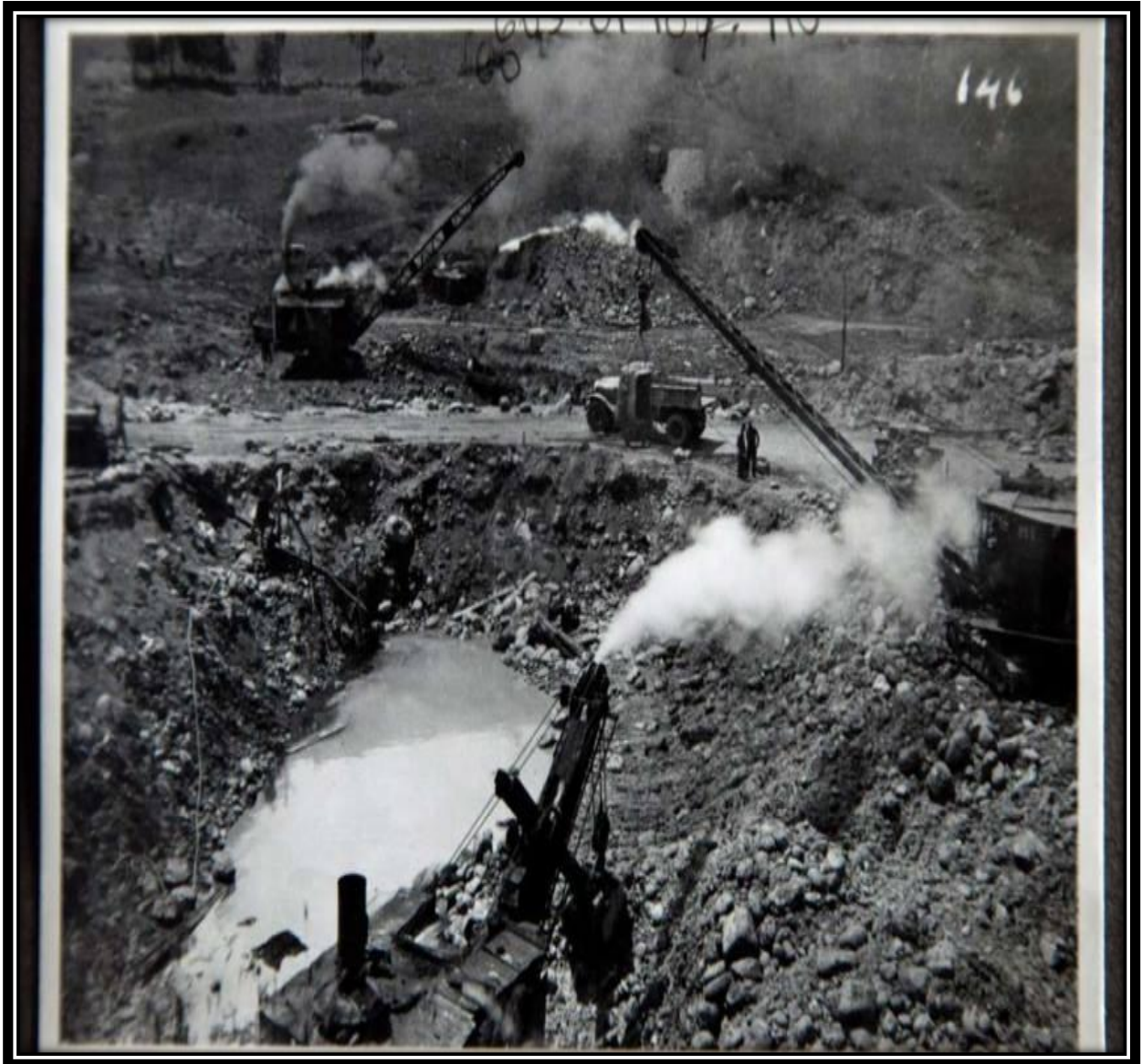
Gráfica 7 Fotografía # 4. Título: Construcción de la Regadera 1934 .Autor Henry Lopez. Fuente: Fotos Antiguas de Bogota
