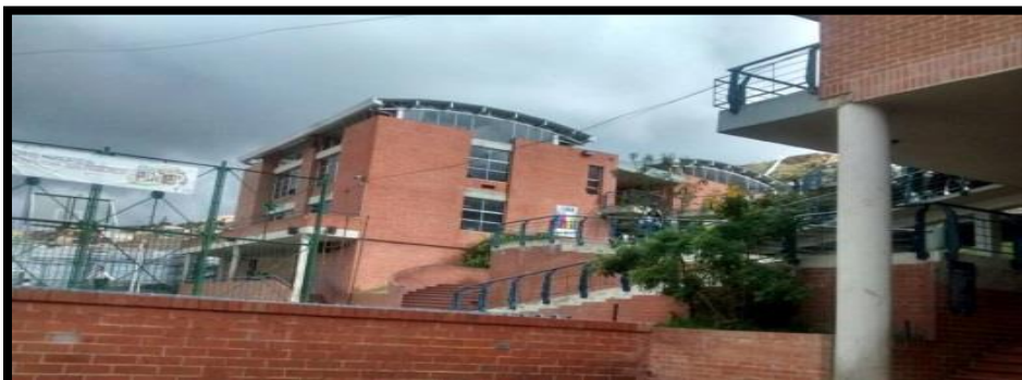
Imagen 2. Fachada Colegio Ofelia Uribe de Acosta I.E.D., sede “A”. Tomada por Gutiérrez, L. 2015
