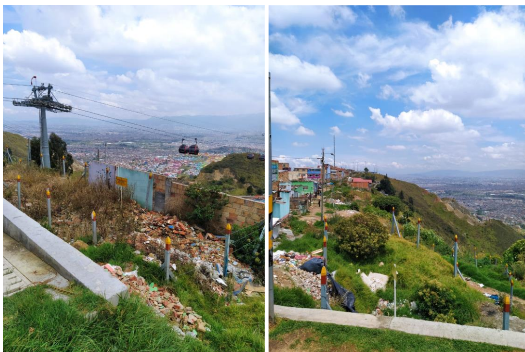
Figura 9 y 10: Encerramiento de lotes adquiridos por el IDIGER en Paraíso- Mirador. Espacio reservado para ejecución de obra del paseo Illimaní. Tramo 1.
