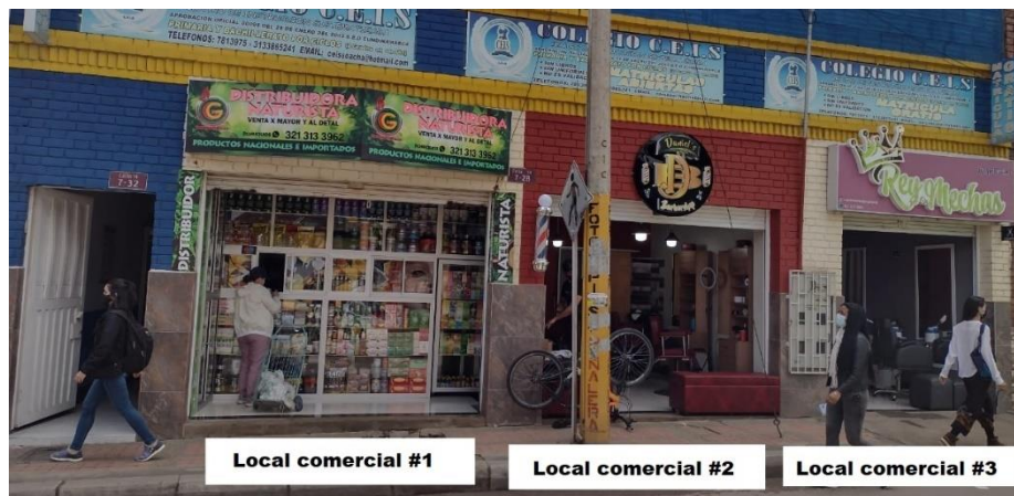
Figura 3. Parte frontal del Colegio CEIS modificada 2020 – 2021.
