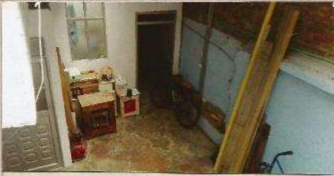
Imagen 20 Fotografía, Registro fijado del patio y de la grieta en la otra casa, a partir de una foto que hace parte del tercer archivo fotográfico familiar. Fuente Proceso de creación. Año 2020.
