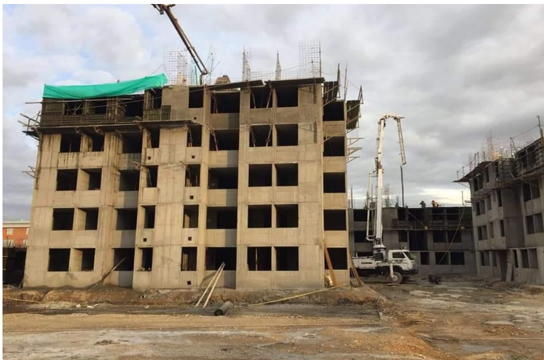
Figura 3.9. Proceso de construcción del conjunto Manzana 65 (Fotografía suministrada por Betty Chacón)
