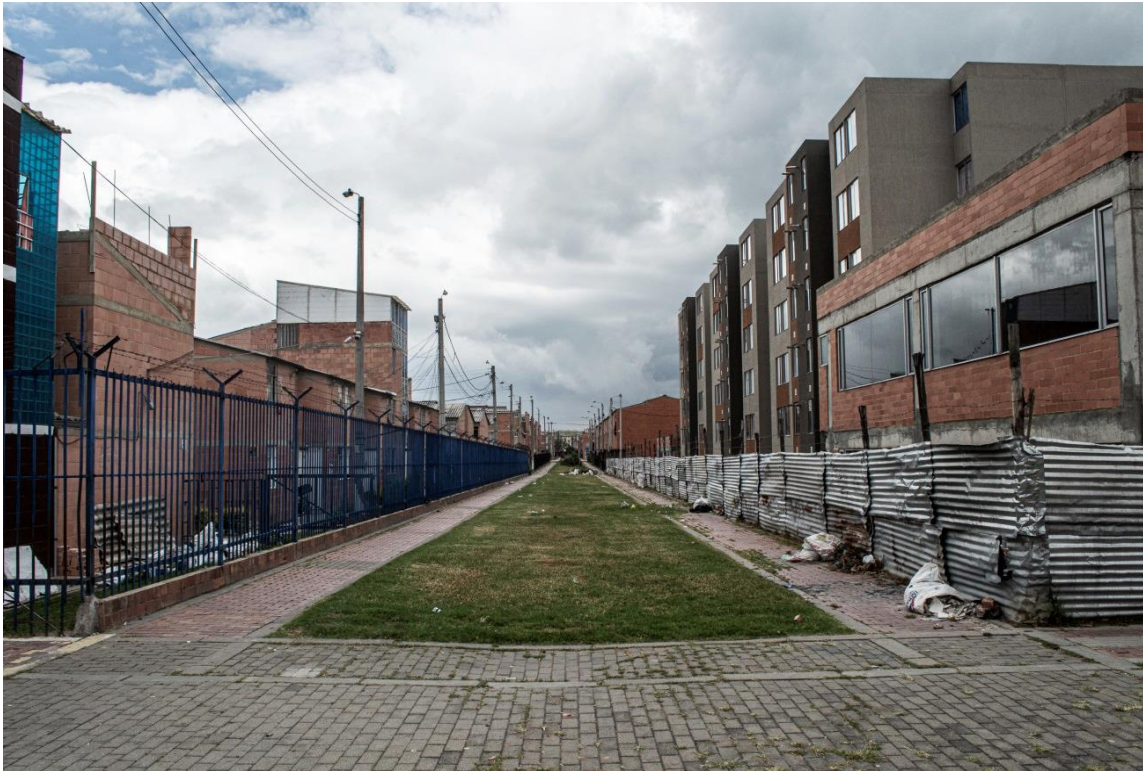
De rejas azules Conjunto Villa Nelly y al frente Manzana 65 Fotografía realizada el 22 de febrero del 2021
