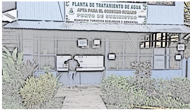
Figura 7. Planta de tratamiento de agua del municipio
