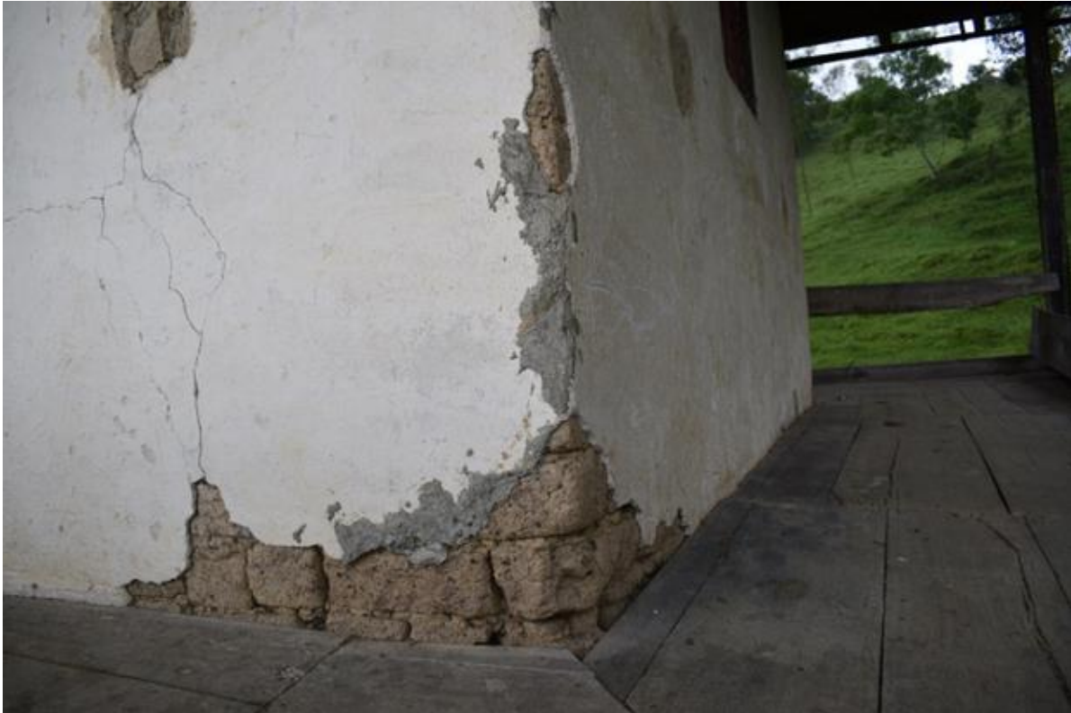
Imagen N 53. Esquina exterior de dos paredes en la casa. Fotografía Rocio.
