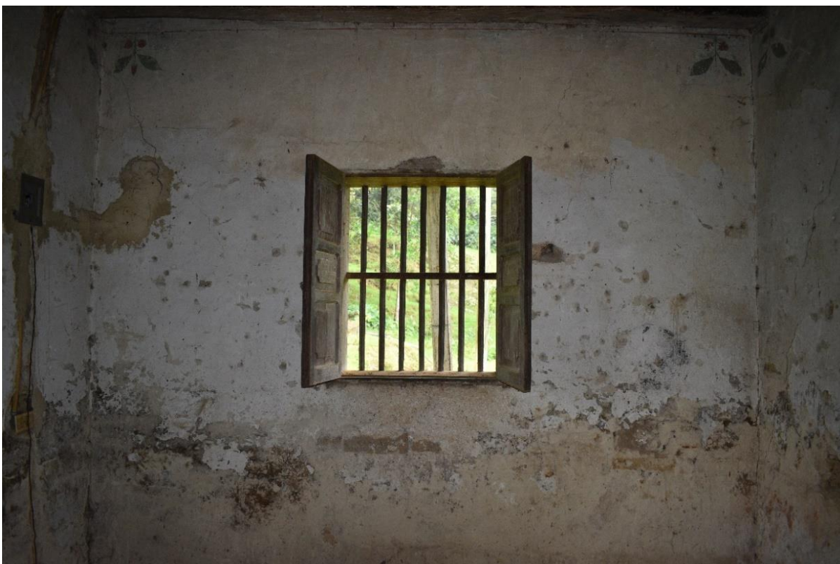
Imagen N 73. Primera intervención. 7 de abril de 2019. Fotografía de Rocio.
