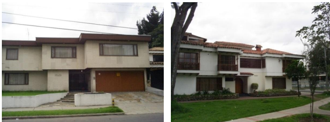
Figura 42. Casas tipo arquitectónico hasta dos pisos
