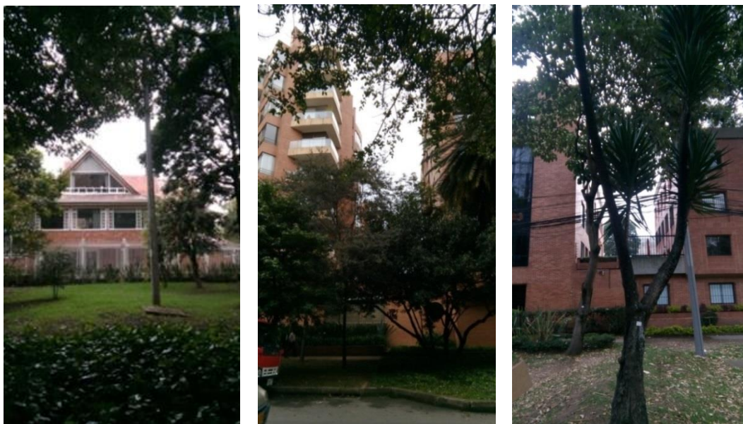
Figura 40. Aislamientos laterales entre edificaciones
