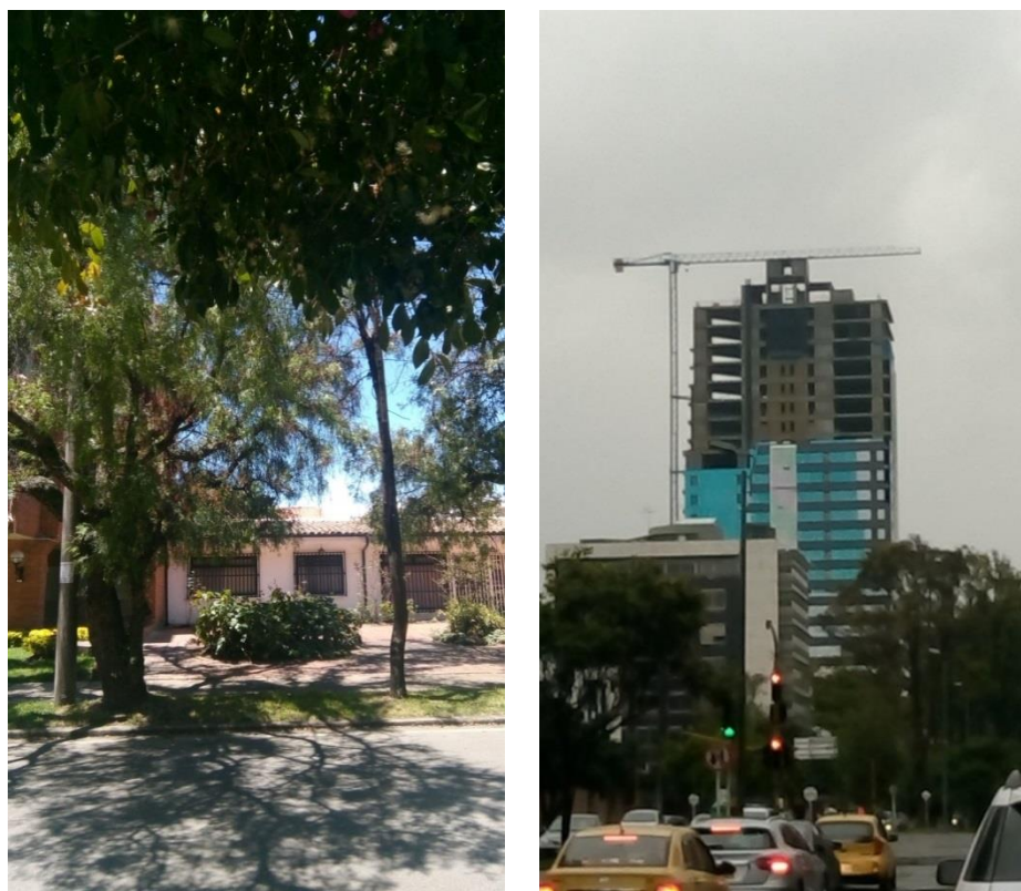
Figura 29. Fotografía casa barrio residencial y edificio Avenida 19
