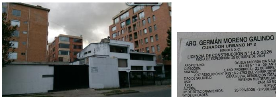
Figura 43. Valla informativa obra nueva con licencia de construcción
