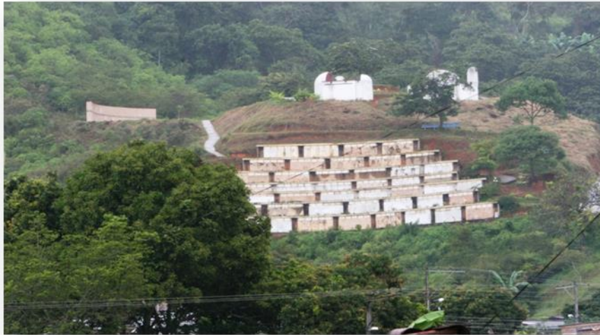
Fotografía No11. Construcción parcial del Parque Monumento, osarios, tumba del padre Tiberio, muro Sombra del amor.
