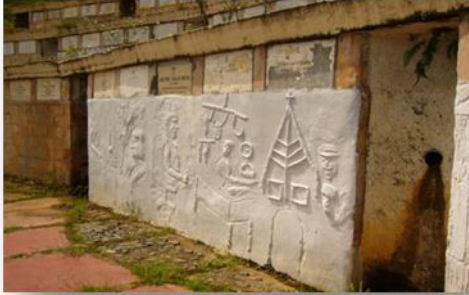
Fotografía No 3. Construcción Osarios. Parque Monumento
