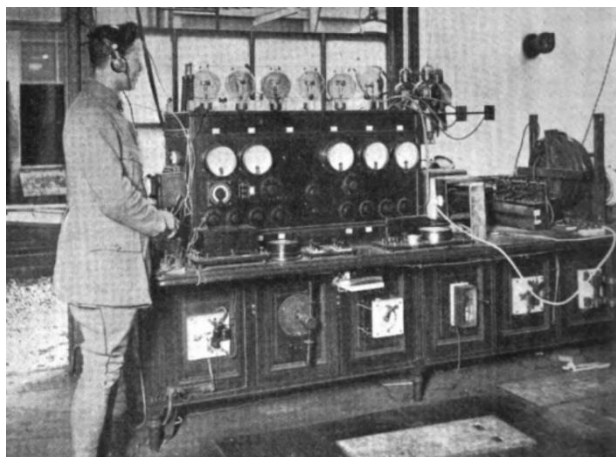
Ilustración 5. Instalaciones de La Poste De La Tour Eiffel.
