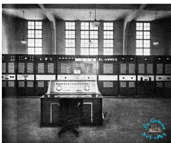
Ilustración 23. Transmisor de Onda Media con su Mesa de Control.
