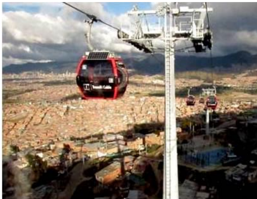
Figura 4. Vista posterior de pylon 23 y cabinas de Transmicable. 16
