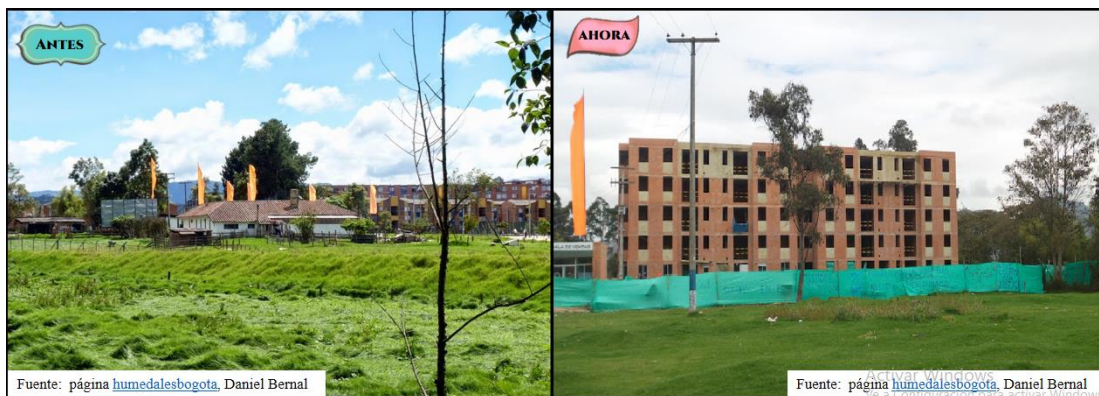
Imagen 2. Antes y después de la urbanización del área protegida de la conejera
