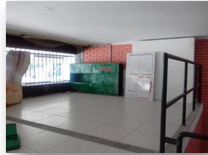
Imagen 32, fotografía parte del mezanine reestructurado
