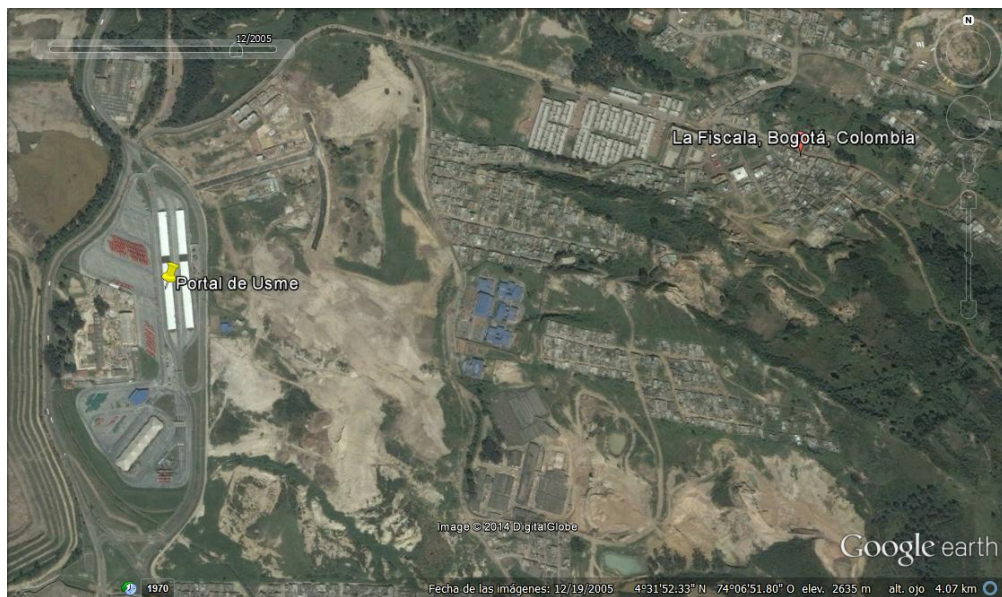
Figura 08. Construcción del Portal de Usme en la Zona de estudio
