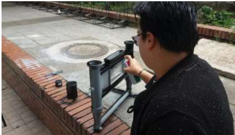
Imagen 41. Fotografía de la aplicación de la primera capa de pintura negra.
