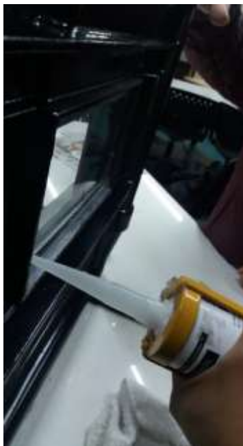
Imagen 44. Fotografía del Refuerzo en los vidrios con silicona.
