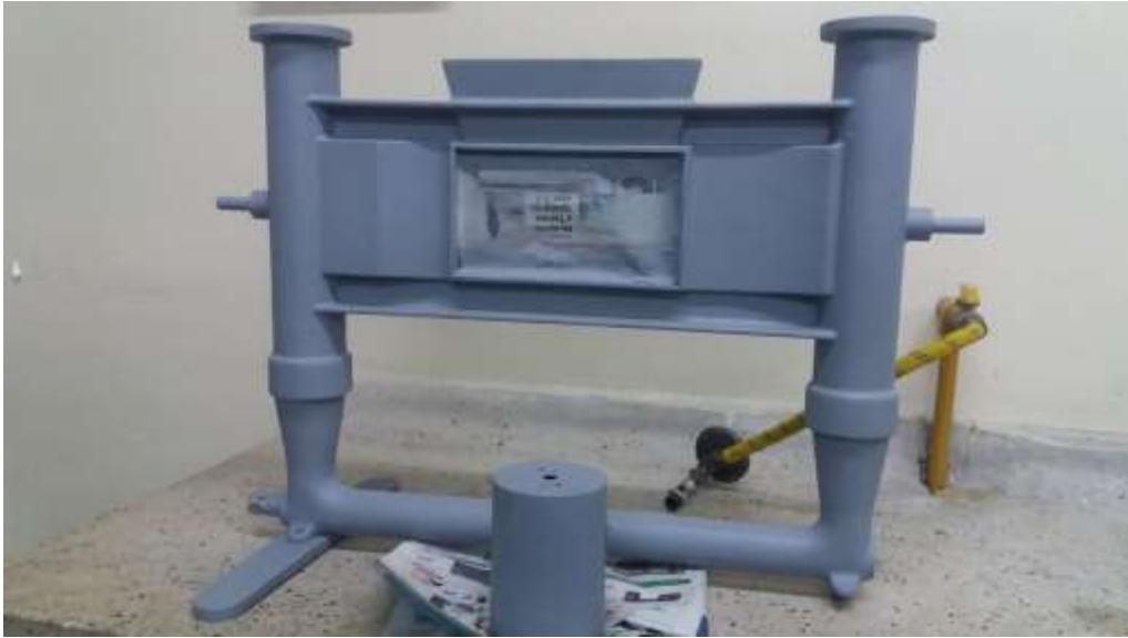
Imagen 40. Fotografía del montaje con pintura anticorrosiva.
