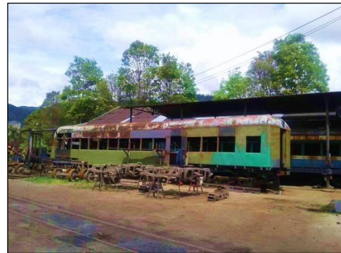
Foto 7. Vagón en estado de deterioro
