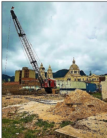
Foto 8. En construcción. Renovación urbana
