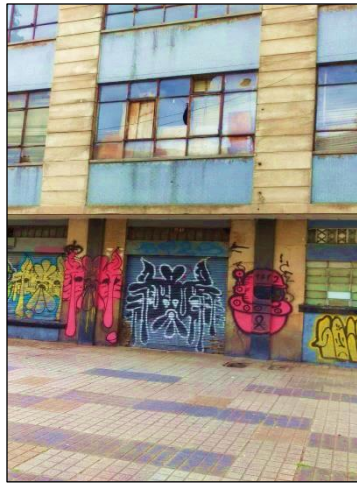
Foto 4. Edificio cercano a la Estación
