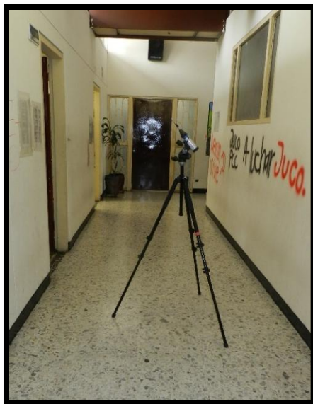
Figura 31. Fachada interna (pasillo) a uno de los costados del aula C220.
