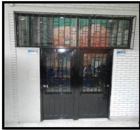
Figura 29. Ubicación de las puertas de las aulas C108 y C109, sobre la fachada.
