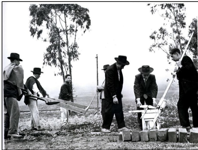
Figura 2 Vecinos de Saucio iniciando la construcción de la escuela usando la máquina Cinva Ram para fabricar bloques.
