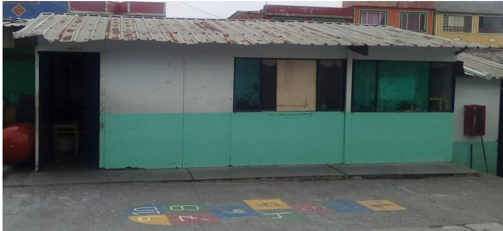
Imagen. 3 Salones recubiertos en Drywall (estado actual)
