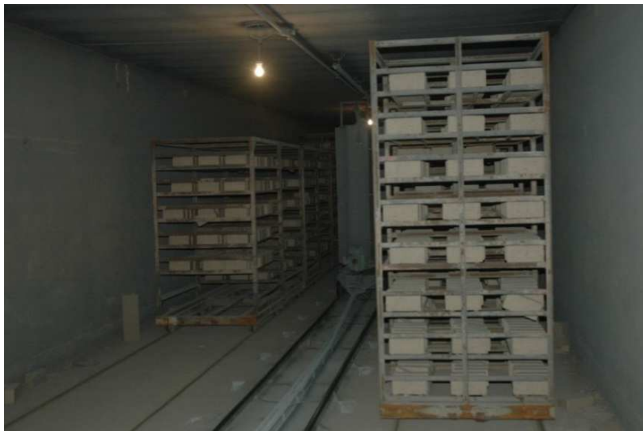
Imagen 65. Líneas férreas y estantes en el interior del secador. 2017.
