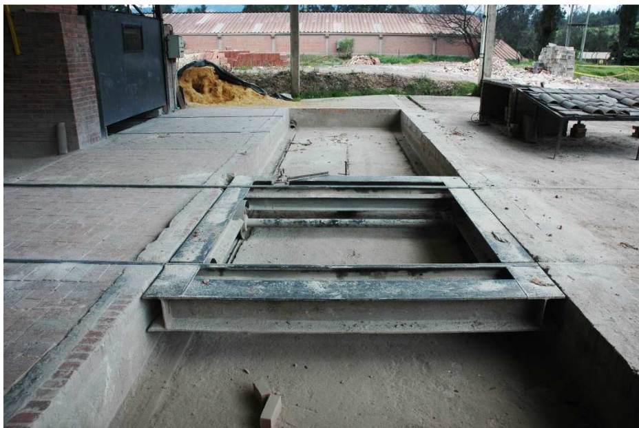
Imagen 71. Transbordador ubicado a la salida del horno. 2017.
