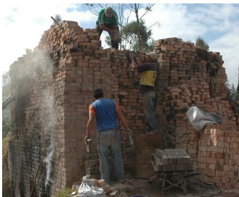
Imagen 26. Sellado del horno empleando ladrillo cocido. 2017.
