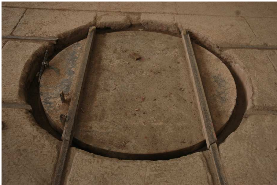
Imagen 97. Tornamesa para girar los estantes en el área de moldeo. 2017.
