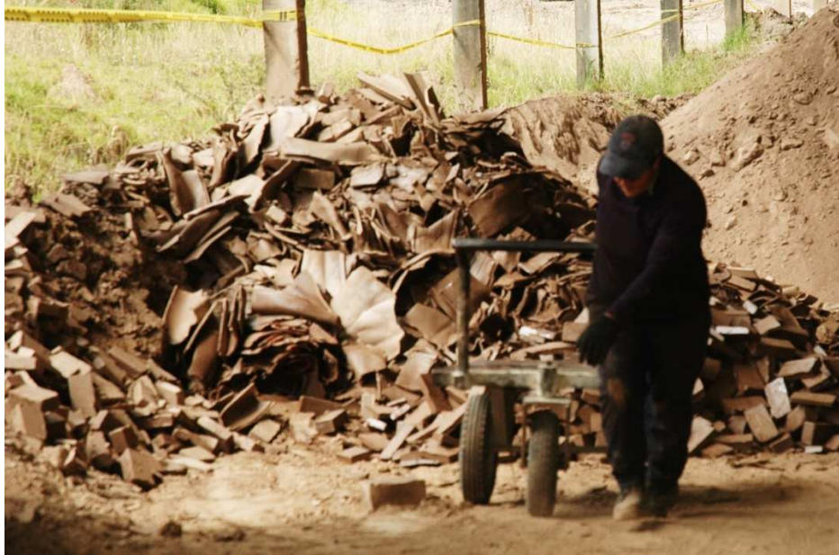
Imagen 58. Refile y desperdicio de la teja y el ladrillo. 2017.
